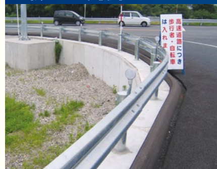
羽越河川国道事務所(新潟県)
