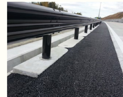
沼津河川国道事務所(静岡県)
