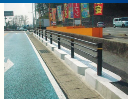
多治見砂防国道事務所(岐阜県)
