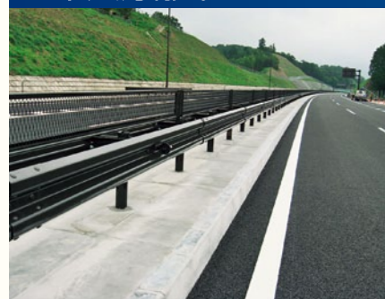
沼津河川国道事務所(静岡県)
