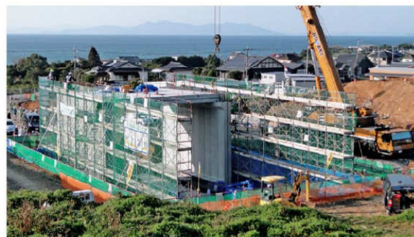
国土交通省鹿児島国道事務所 鹿児島3号出水北IC函渠工事 B10000×H6600
