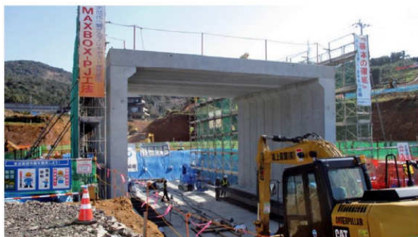
国土交通省鹿児島国道事務所 鹿児島3号出水北IC函渠工事 B10000×H6600
